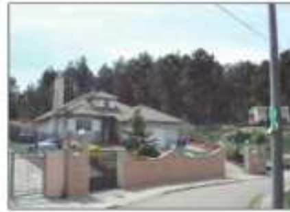
Lote 56 Vivienda unifamiliar en vidreres
