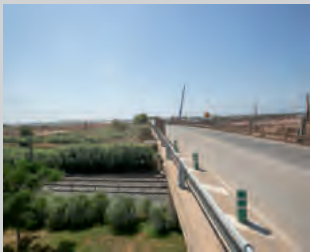
REMODELACIÓ DEL PONT DE LA B-204
