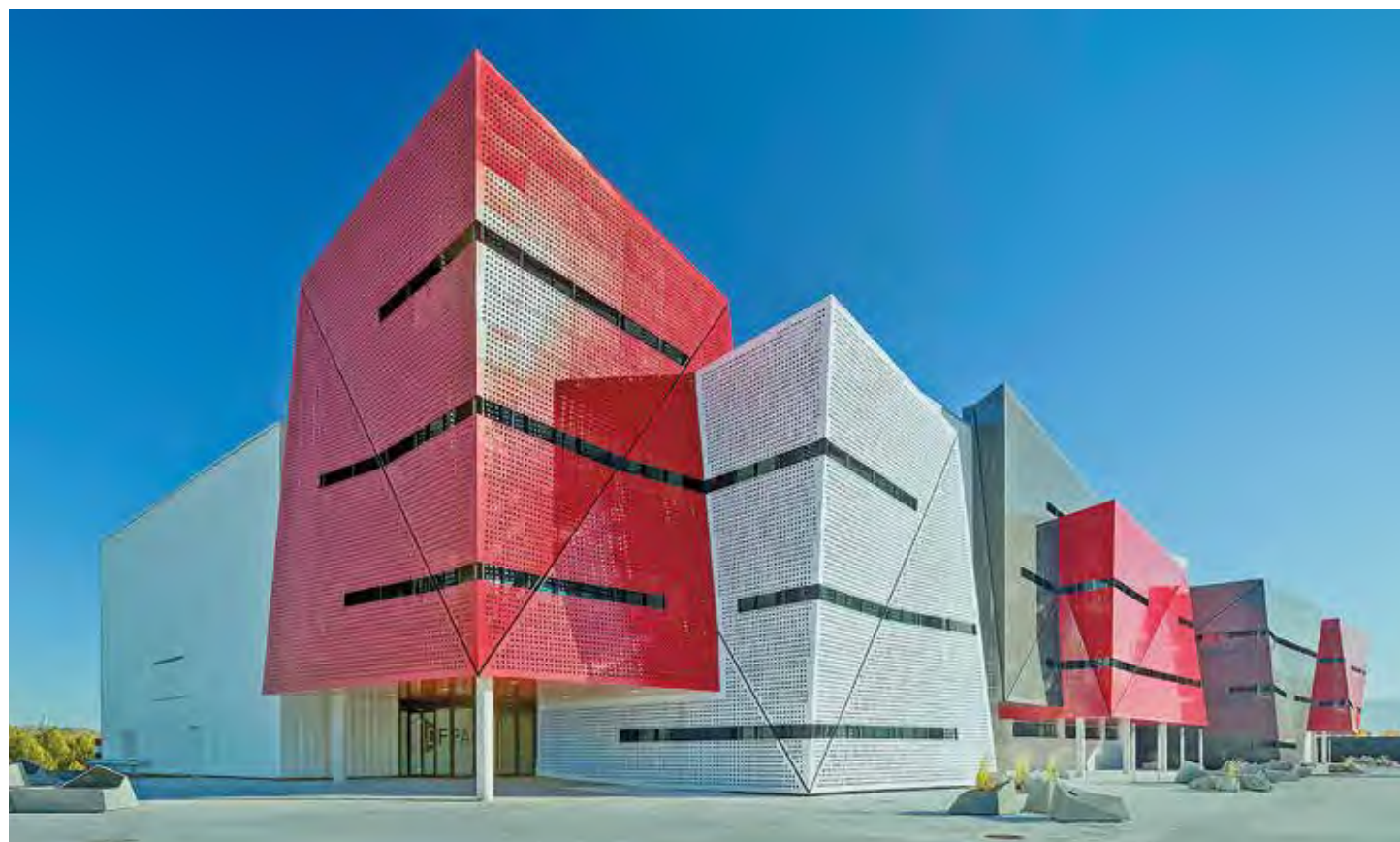
FACHADA PRINCIPAL DEL CENTRO DE FORMACIÓN PROFESIONAL DE AUTOMOCIÓN DE MARTORELL
