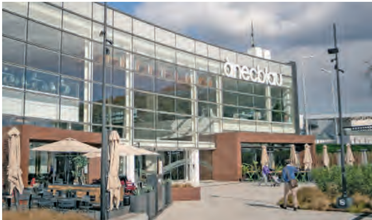
NEUA FACHADA ACRISTALADA DE ÀNECBLAU DE CASTELLDEFELS
