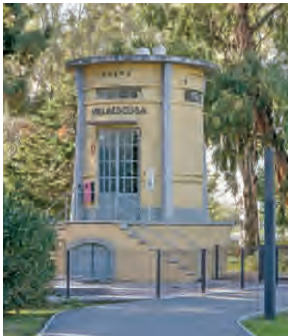
POU D'AIGÜES DE BARCELONA A LA CENTRAL CORNELLÀ
