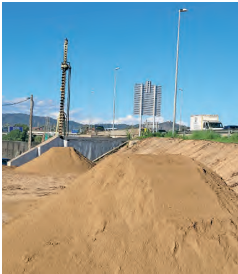
ÁRIDOS QUE SE UTILIZAN EN LA AMPLIACIÓN DE LA PLATAFORMA VIARIA SOBRE EL RÍO LLOBREGAT
