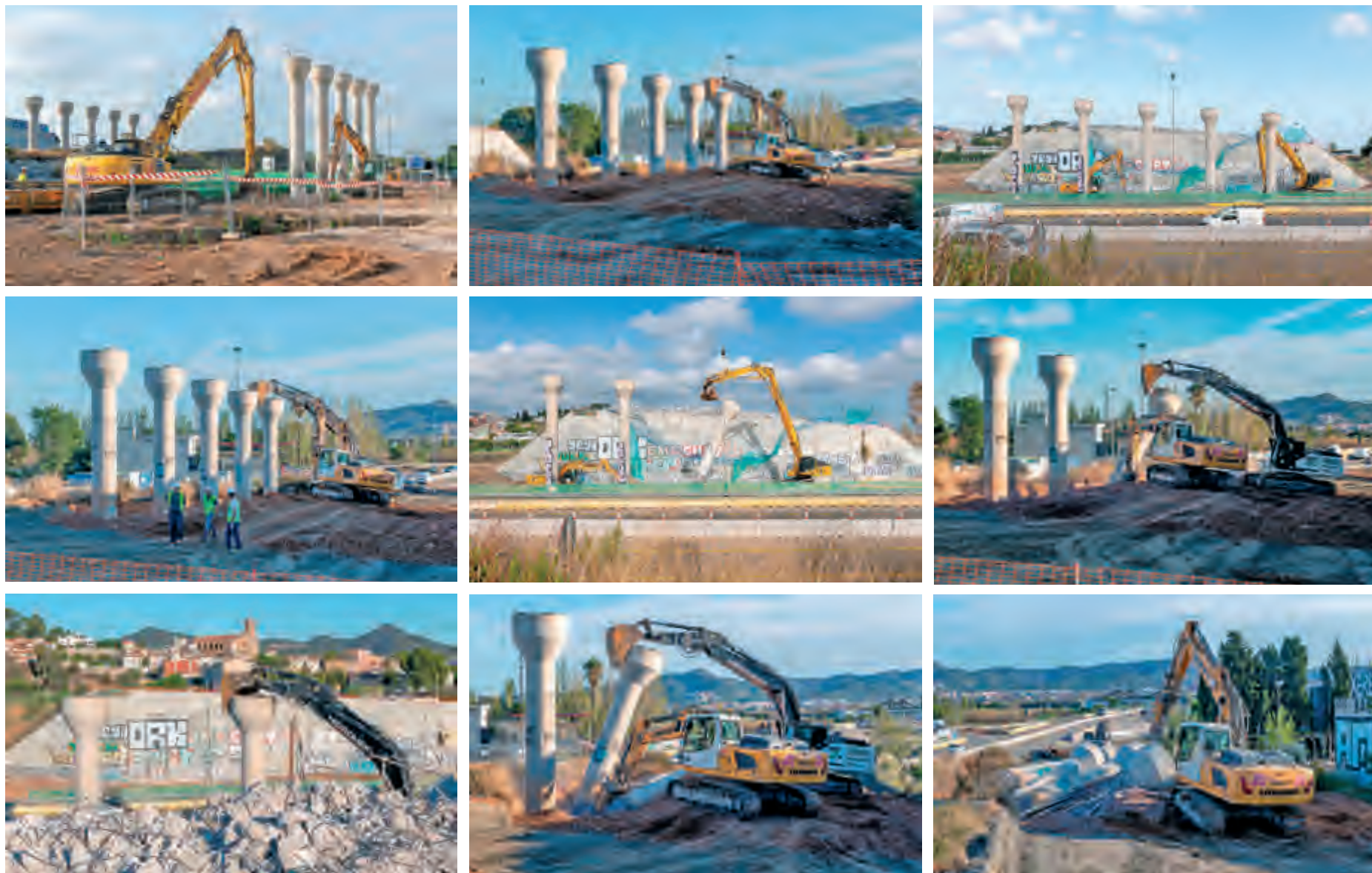
SECUENCIA DEL DERRIBO DE LAS COLUMNA DEL ANTIGUO TRAZADO DE LA B-25 QUE HAN QUEDADO INSERVIBLES Y QUE RECIBÍAN A LOS AUTOMOVISTAS EN LA ENTRADA A SANT BOI POR LA C-245 (FOTOS: MARÍA JOSÉ REYES)
